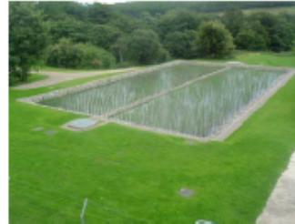
**Alcance de los trabajos:** ARM diseñó y construyó un sistema de tratamiento basado en humedales de flujo horizontal, de 800m<sup>2</sup>, para eliminar el cobre presente en las aguas residuales provenientes de la destilería.
