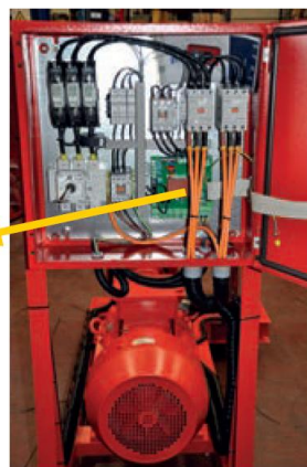
Detalle de cable utilizado en los equipos EBARA que cumple con la norma UNE 211025.
